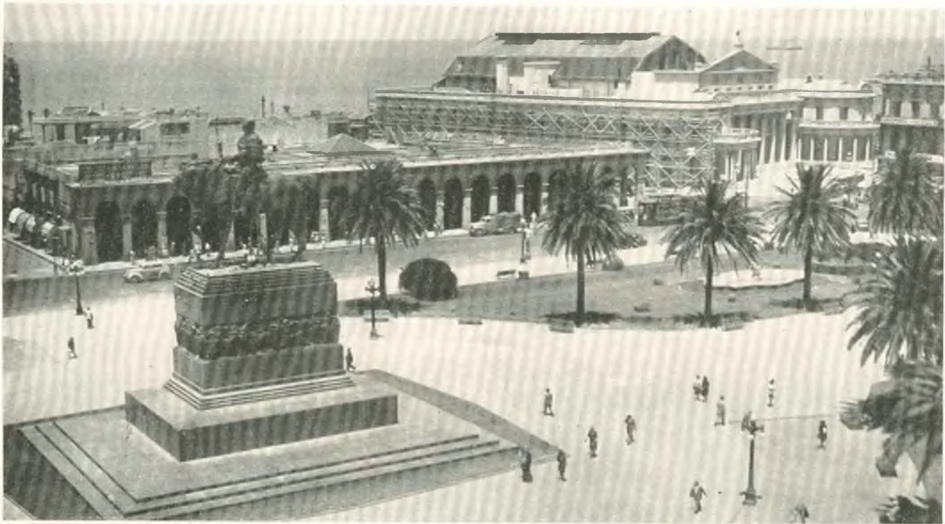
Lado Sur de la Plaza. Tramo de la arquería de "La Pasiva" después del derribo de los edificios que existían entre ésta y el Teatro Solís.
