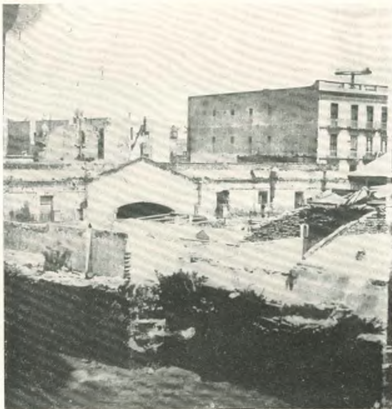
Vista hacia la calle Juncal donde estaba la puerta de la Ciudadela. Se ve la casa de cuatro pisos y entresuelo que aún existe. (Foto de 1877).
