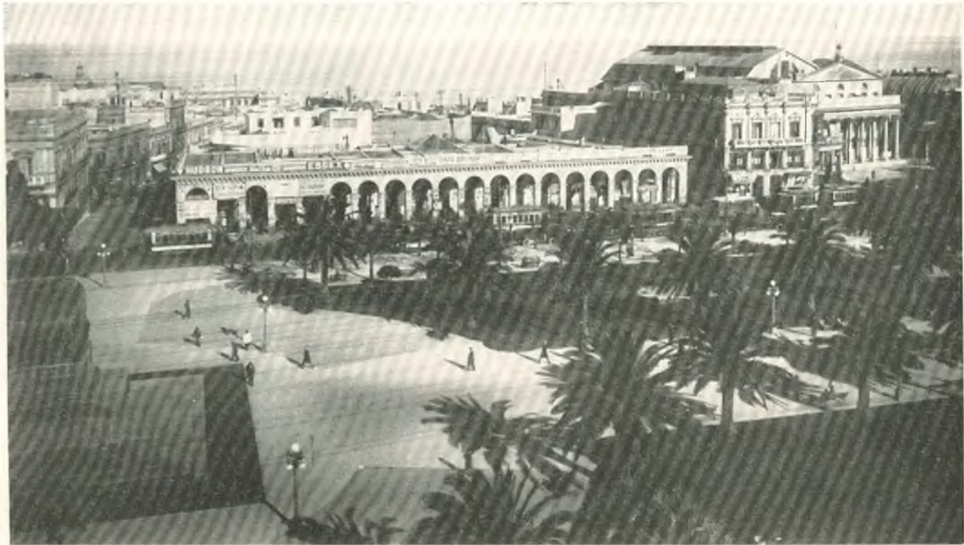
Lado Sur. Muestra esta foto la arquería y el edificio de Pons levantado en 1889, sin sujeción al plan de uniformidad arquitectónica, entre las calles Juncal y Liniers.
