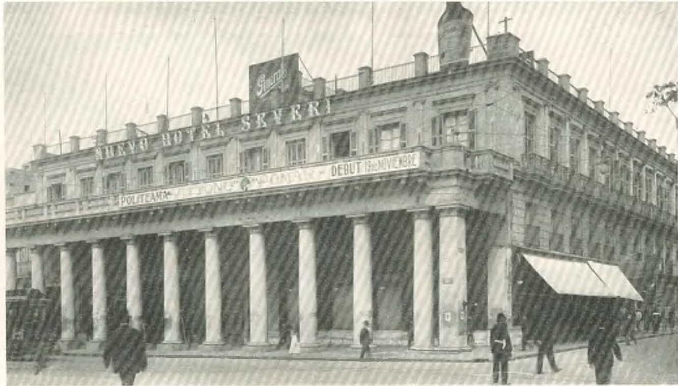
Lado Oeste, esquina Juncal y Sarandí. Esta foto muestra la forma en que se adosó el pórtico, sin atender los niveles del entresuelo y del piso alto.
