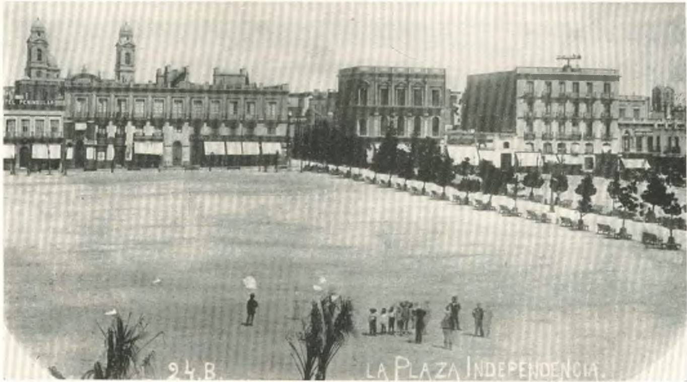
Lado Oeste sobre la calle Juncal, cuando todavía no se le había adosado el pórtico a los edificios existentes
