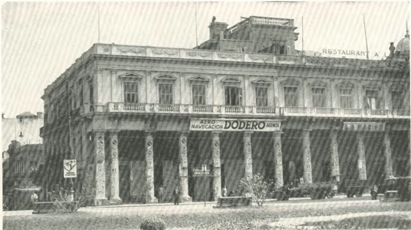
Lado Norte, en la esquina Florida, donde se vé la falta de correspondencia en el nivel del arquitrabe del intercolumnio, consecuencia del incidente promovido por don Vicente Vásquez.
