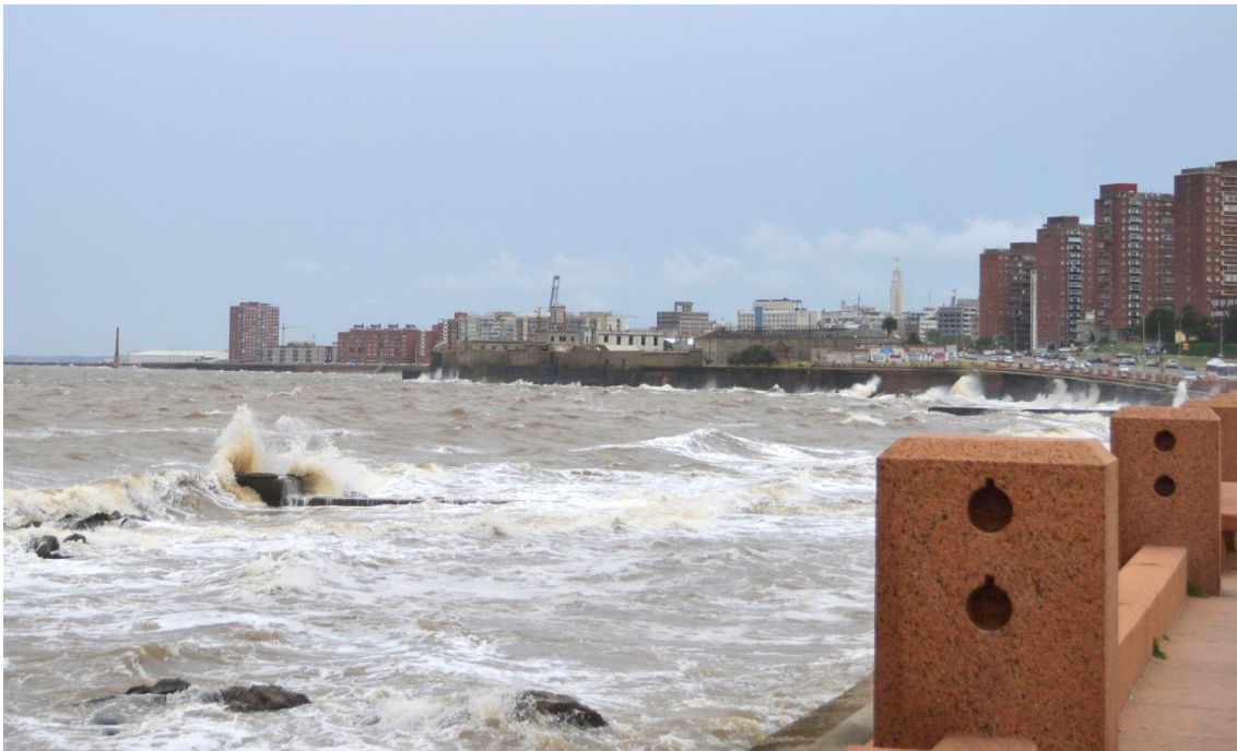
Vista actual del dique del gas, sur de Montevideo.
