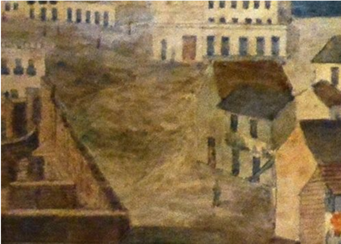
Detalle del Teatro Solís en construcción
